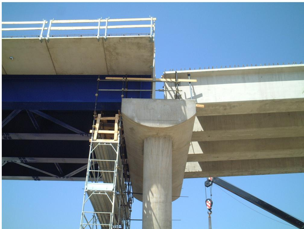
Foto 3 – Particolare pila di transizione tra impalcato a struttura mista e impalcato in c.a.p.
