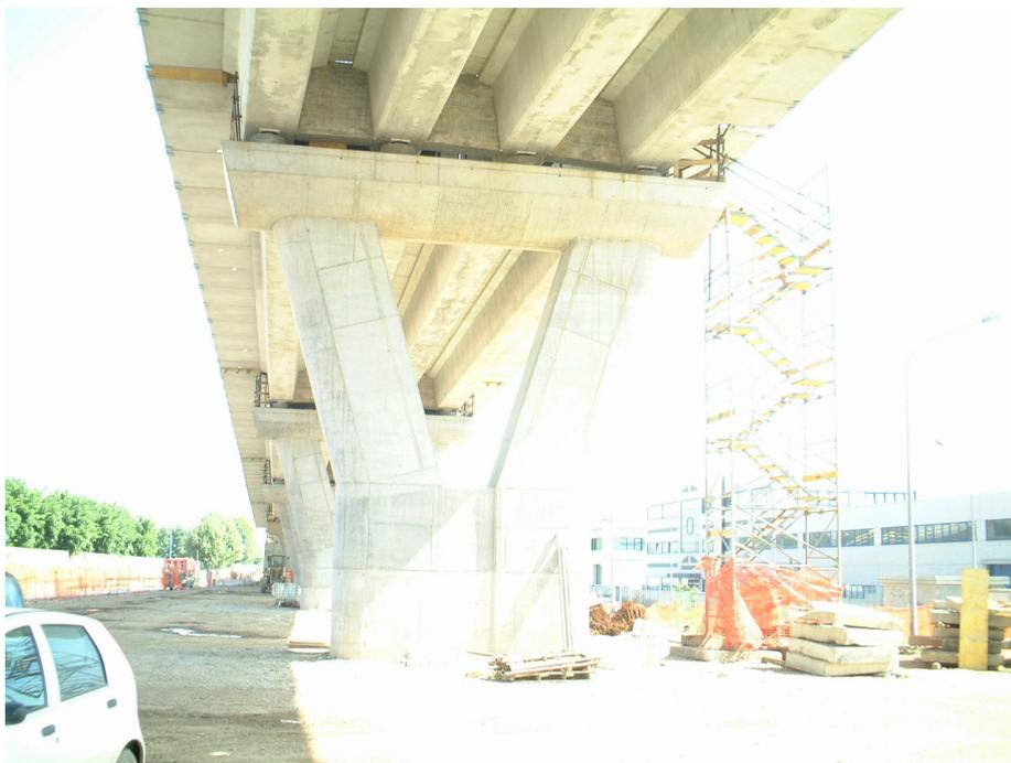
Foto 2- Viadotto in c.a.p. in costruzione lungo la Torino-Milano simile a quelli di progetto
